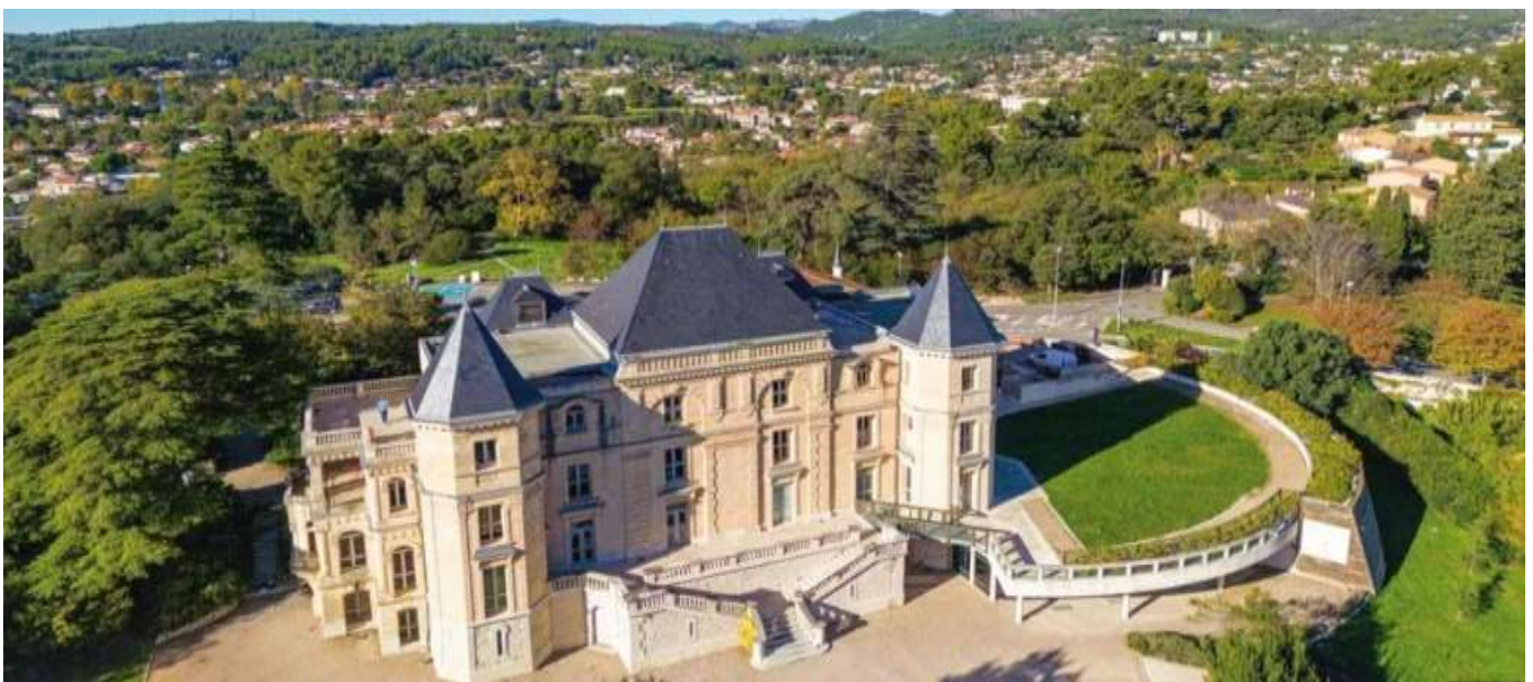
บ่าย นำท่าน แวะถ่ายรูปกับปราสาท ลองชองป์ (Palais de Longchamp) เป็นอาคารและสวนสาธารณะที่มีชื่อเสียงใน มาร์กเซย์ ประเทศฝรั่งเศส สร้างขึ้นเพื่อเฉลิมฉลองการสร้างคลองมาร์กเซย์ ซึ่งนำน้ำจากแม่น้ำคูร์องซ์มายัง เมือง และถือเป็นความสำเร็จทางสถาปัตยกรรมที่แท้จริง ปาแล ลองชองป์ เป็นที่ตั้งของพิพิธภัณฑ์สถาน ธรรมชาติวิทยา และพิพิธภัณฑ์วิจิตรศิลป์ สร้างขึ้นใน ค.ศ. 1839 และแล้วเสร็จใน ค.ศ. 1869 ออกแบบโดย สถาปนิก อองรี-ฌาคส์ เอสเปร์องดีว (Henri-Jacques Espérandieu) โดยมีน้ำพุขนาดใหญ่และอถังการเป็น
