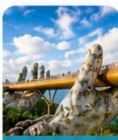
สะพานมือสีทอง
